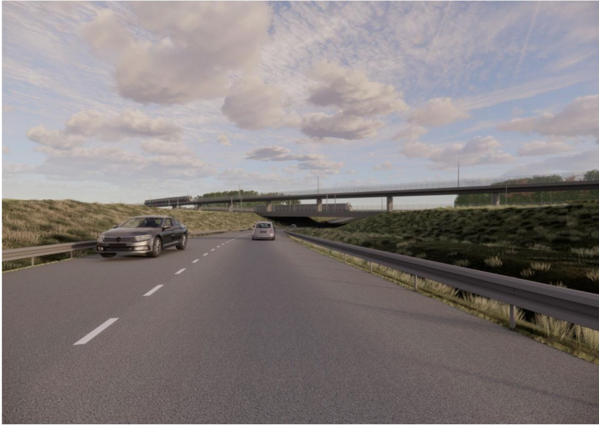
Visualisering av möjlig utformning av ny järnvägsanläggning över Kallerstadsleden i nytt läge. Detta alternativ visar hur den skulle kunna se ut med en planskild passage mellan spåren.
