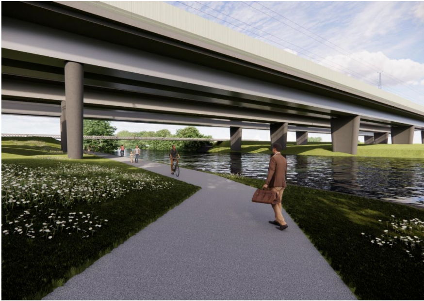
Visualisering av hur järnvägsbro över Stångån skulle kunna se ut med gång- och cykelväg under bron. Bilden visar exempel på en så kallad samverkansbro.
